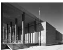
Bâtiment central de la bibliothèque publique de Regina (vue extérieure de l'entrée et de la façade nord), construit en 1962 par Kiyoshi Izumi, v.1963. Photographie de Henry Kalen. Archives et collections spéciales de l'Université du Manitoba, fonds Henry Kalen, PC 219 (A.05-100), boîte 155, dossier 495, pièce 3. Avec l'aimable autorisation des Archives et collections spéciales de l'Université du Manitoba.
